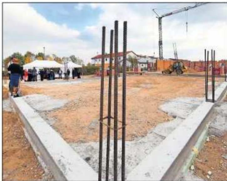
Im Hintergrund rechts wachsen bereits die Mauern des künftigen Drogeriemarkts in die Höhe.
