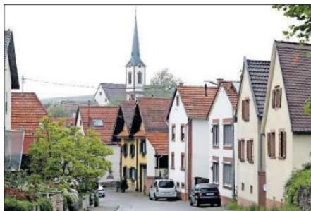
Im Münsterweg soll die Anlage entstehen. FOTO: VAN
