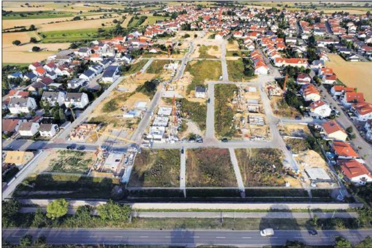
Hinter der Mauer wird gearbeitet: das Neubaugebiet in Heiligenstein zwischen Viehtriftstraße und Salierstraße.
