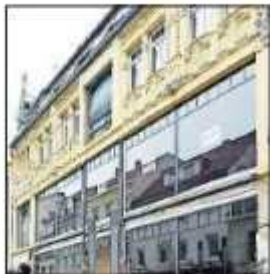
Die neuen Fenster sind eingebaut. FOTO: MEHN
